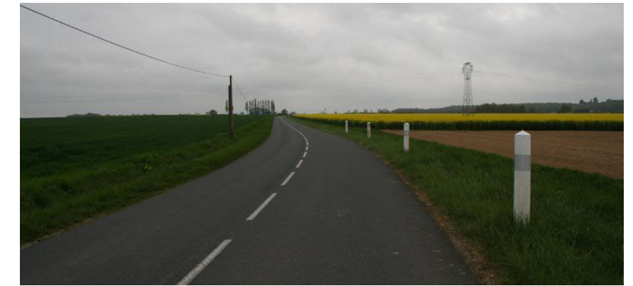
Photo 17 : RD922 en sortie de Graçay, en direction de Reboursin (Rodolphe Chemière)
